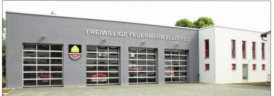
Die Freiwillige Feuerwehr Ellefeld verfügt nun über ein neues Gerätehaus mit Schulungsraum, Sozialtrakt und Fahrzeughalle.
